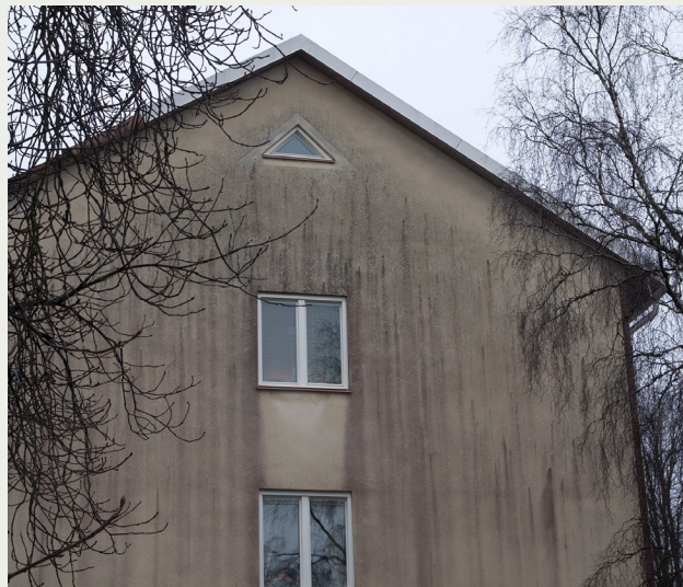
Figur 1. Exempel på hur fasadens utformning kan påverka vattenavrinning och därmed påväxt. Överhäng från takfoten har skyddat så att inte regn har runnit utför denna del. Även under fönstren saknas sådan påväxt som finns på övriga fasaden. Detta kan bero på att denna del av fasaden har skyddats mot vattenavrinning. En alternativ förklaring är att väggen är varmare under fönstret, till exempel på grund av att radiatoren är placerad där, och att den relativa fuktigheten därmed blir lägre.
